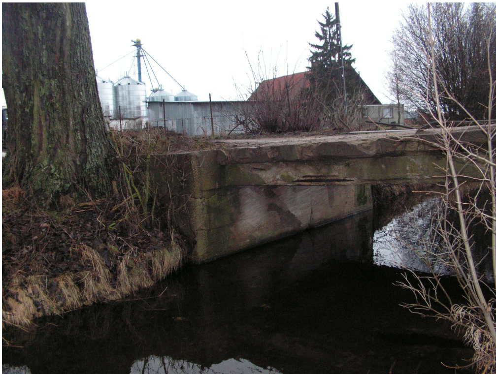
Widok mostu od strony S.
