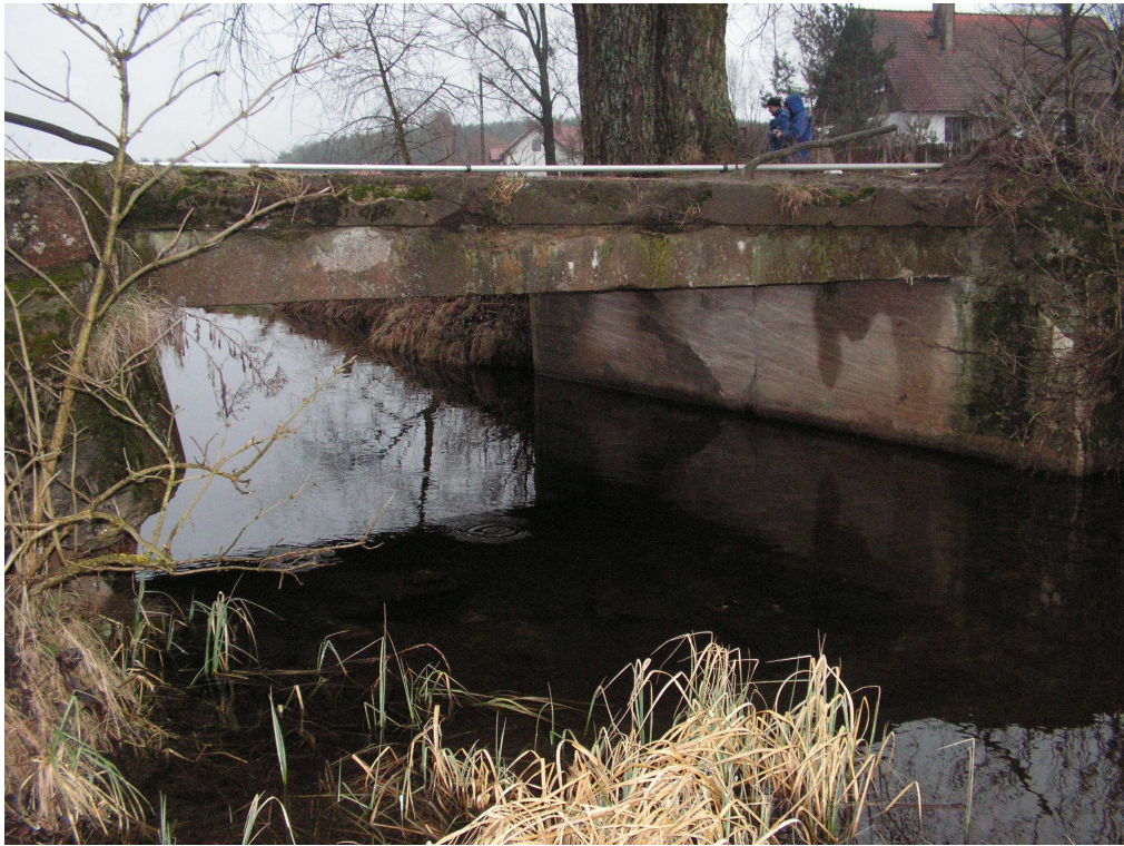
Widok mostu od strony N.
